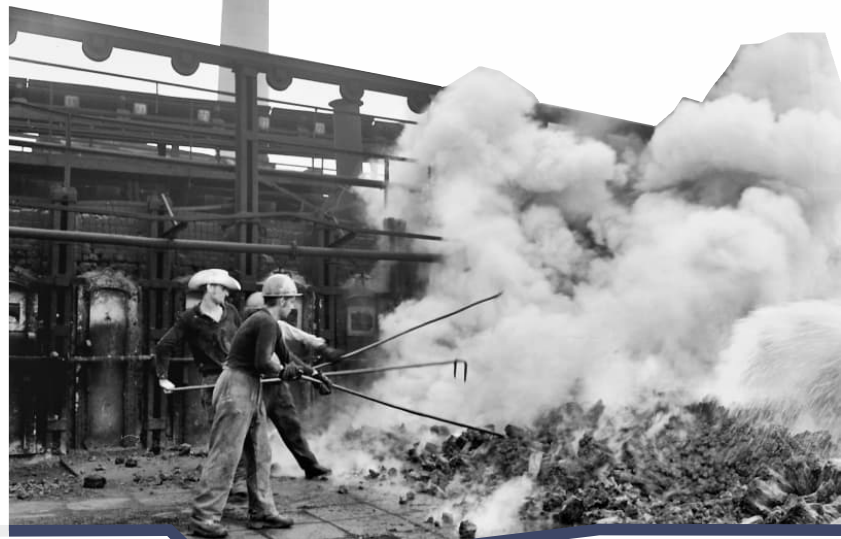
ręczne rozbijanie koksu manual breakdown of coke
