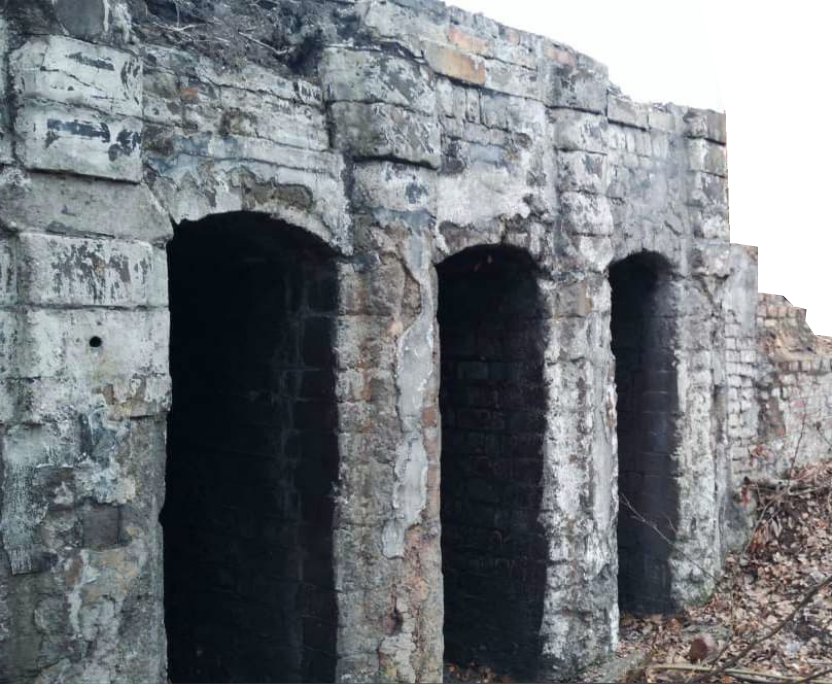
górna bateria koksownicza 2018 upper coke battery 2018
