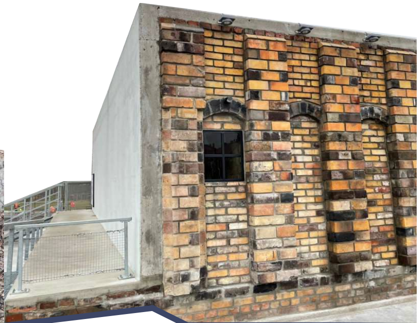
górna bateria koksownicza 2020 upper coke battery 2020
