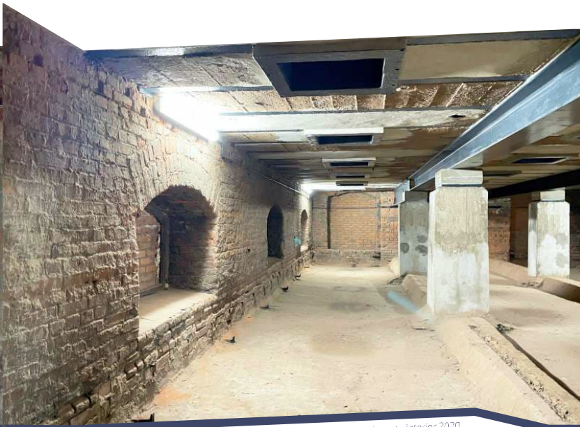
wieża węglowa - wnętrze 2020 coal tower - interior 2020
