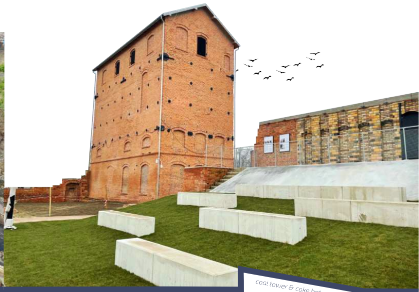
wieża węglowa i bateria koksownicza 2020
